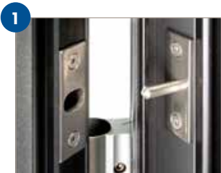
BOLZENSICHERUNGEN im oberen und unteren Bereich der Bandseite verhindern das Aushebeln des Türflügels (Einbruchschutz)
